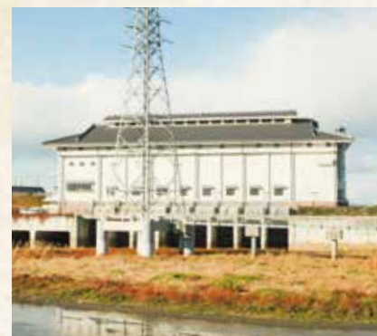
巨椋池排水機場
