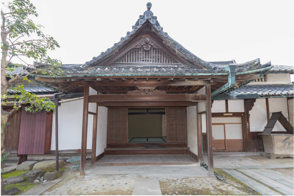
旧山田家住宅 主屋 正面外観
