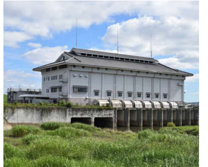
巨椋池排水機場
