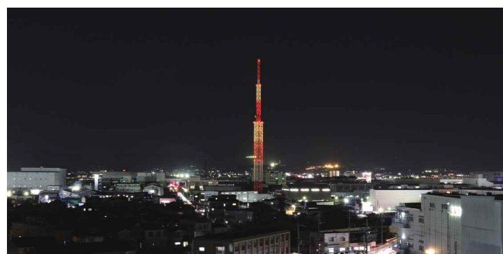
いちきんなな くみやま夢タワー137
