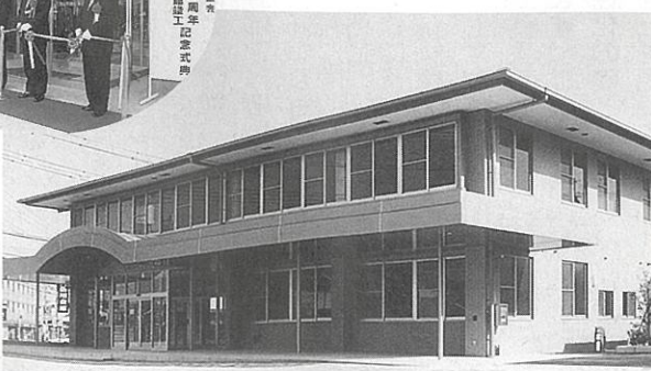
▲商工会館完成
