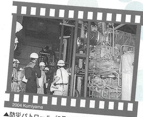
2004 Kumiyama ▲防災パトロール (5月27日・巨椋池新排水機場)
