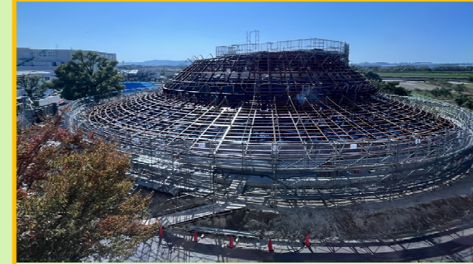
一般部鉄骨建て方完了 (R7. 11. 8)
