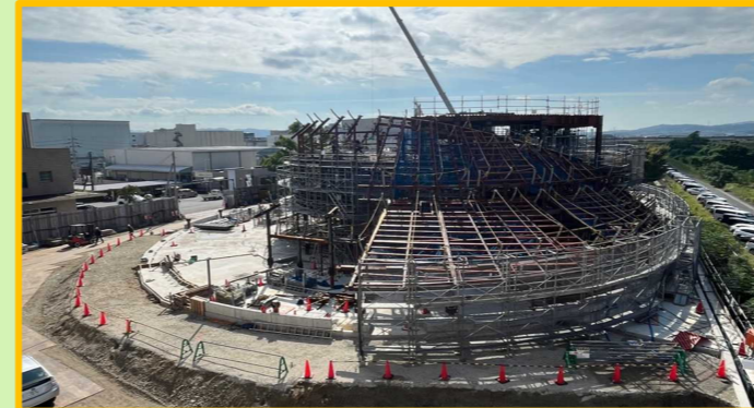
一般部鉄骨建て方 (R7. 7. 23)
