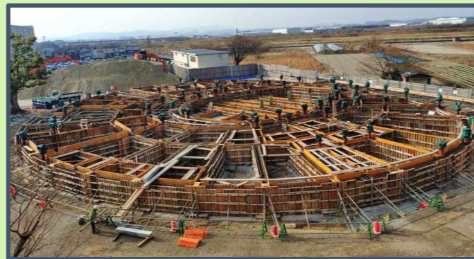
基礎梁配筋 (R7. 2. 27)
