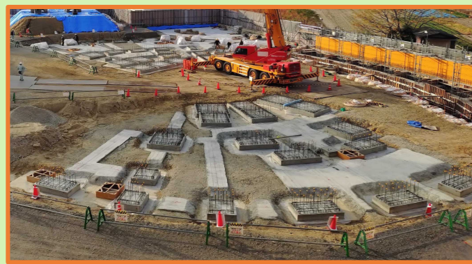
▲ フーチング基礎コン打設 (R6. 12. 20)
