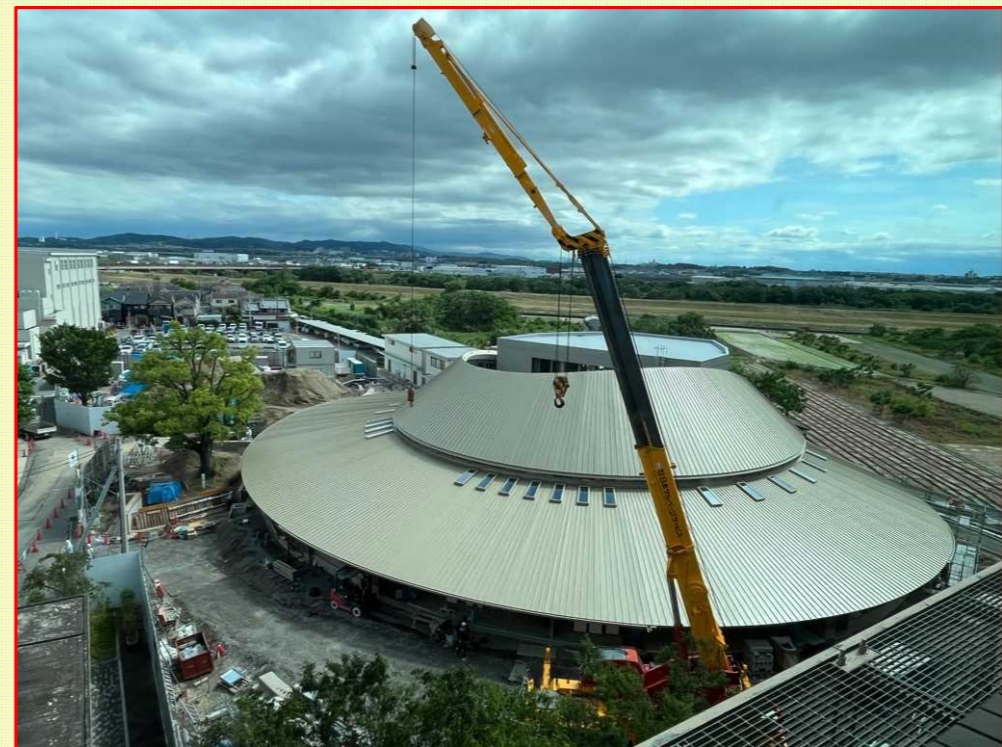
屋根工事完了・外構、内外装等を並行して施工中 (R8. 5. 26)
