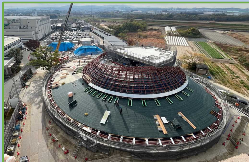
▼ 屋根・防水下地施工 (R7. 12. 10)
