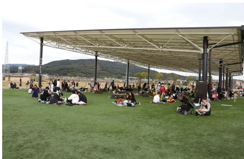
図表 参 2-6 安満遺跡公園内の SAKURA 広場の「大屋根」
