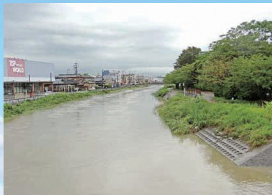
▲危険水位に達する古川 (平成24年水害)
