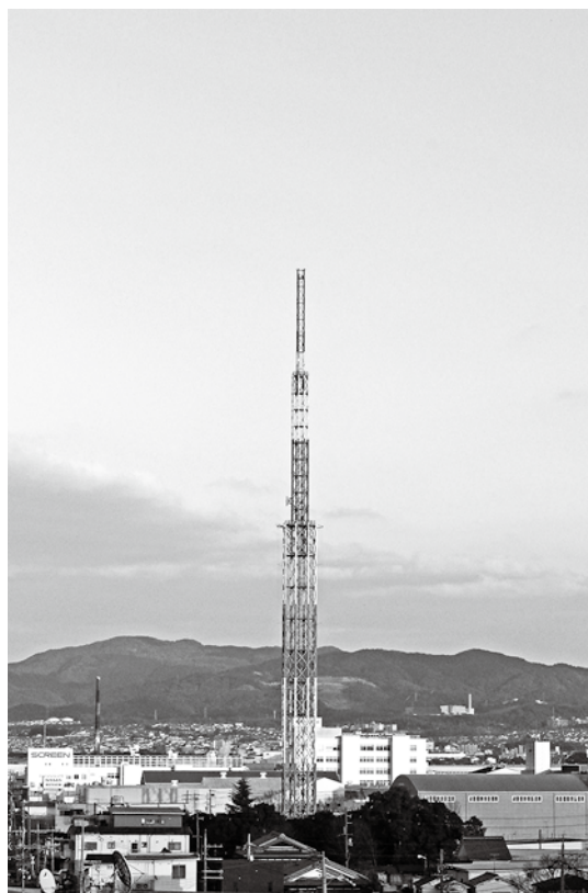
3月24日から3日間、試験点灯でライトアップされるKBS京都のラジオ電波塔
