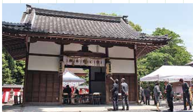
▲修理保存工事が完了した雙栗神社拝殿
