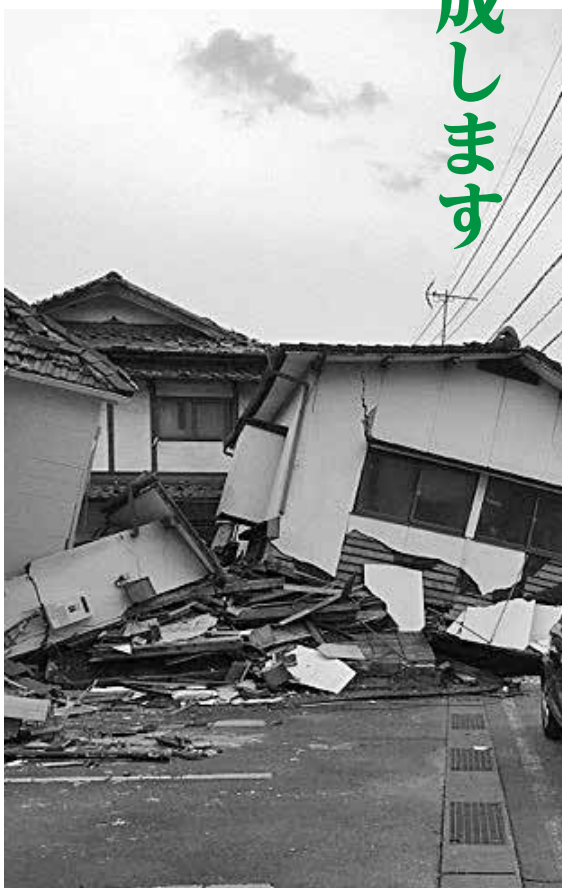
4月に発生した熊本地震で倒壊した家屋（熊本市内）
