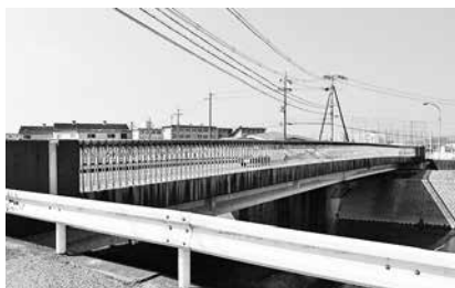
橋の点検と維持補修を行います
