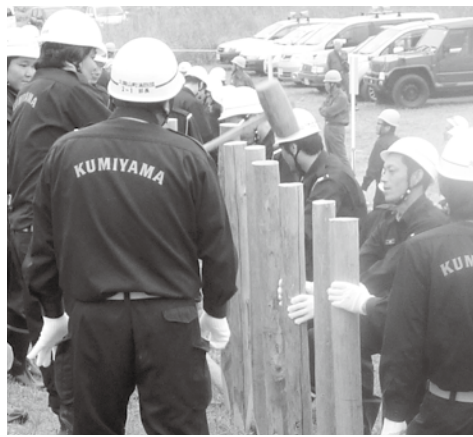
杭打ち積み土のう工の訓練に取り組む久御山町消防団（淀川・木津川水防事務組合水防訓練）
