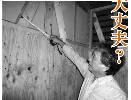
▲耐震改修の様子
