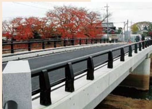
▲11月28日に開通した東一口の前川橋
