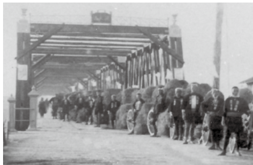
▲檜材を使用した初代の淀大橋
