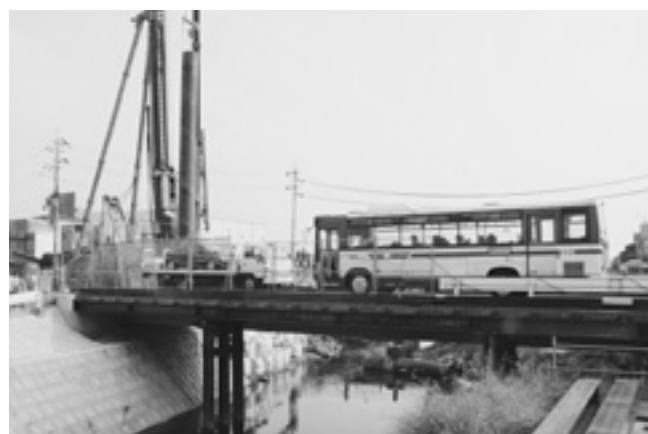
一新される古川橋の架け替え工事
