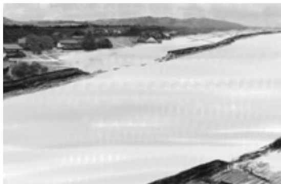
▲木津川左岸で決壊、濁流は八幡方面に流れた
