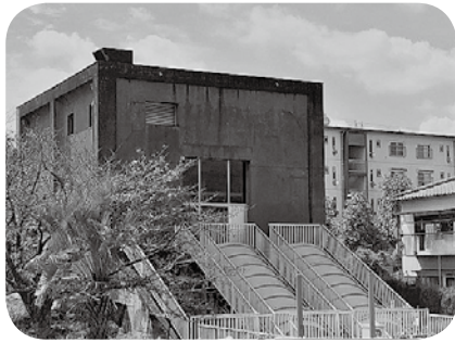
佐山排水機場
