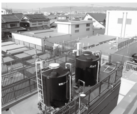
佐古浄水場 沈殿池
