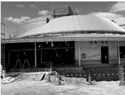
工事が進み、グランハットの形を現しつつある
