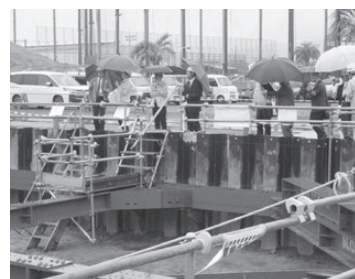
荒見調整池工事現場の視察状況
