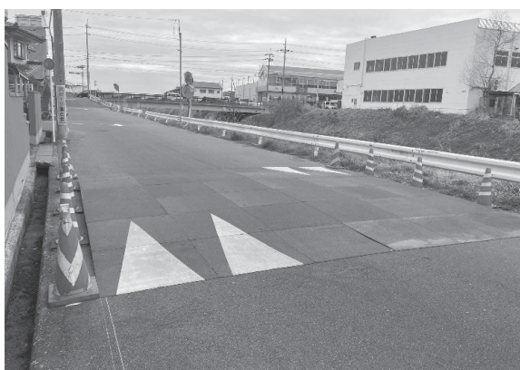
実施された仮設ハンプの様子
