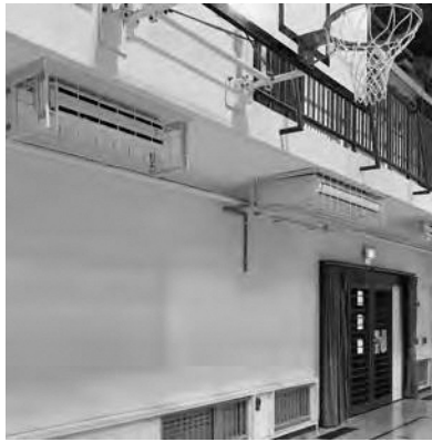
空調設備のある八幡市の中学校体育館
