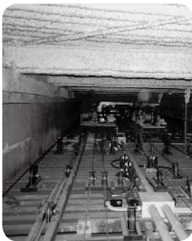
密閉されている天井裏アスベスト
