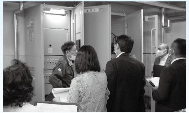
更新された直流電源装置（役場庁舎）
