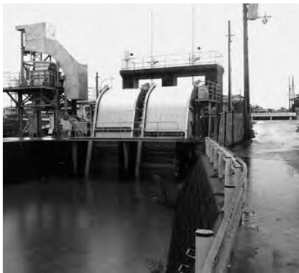
排水機能不足の大内サイホン
