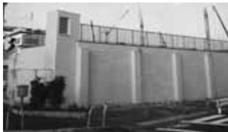
佐古浄水場第一配水池耐震工事
