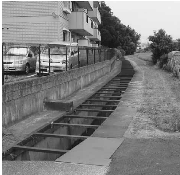
危険が指摘される農業用水路
