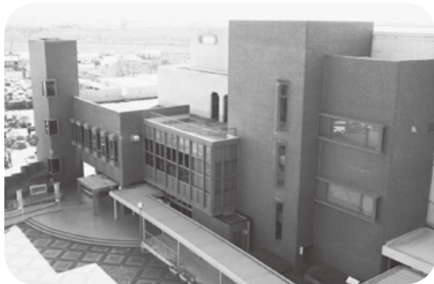
大ホールのアスベスト除去を実施（中央公民館）
