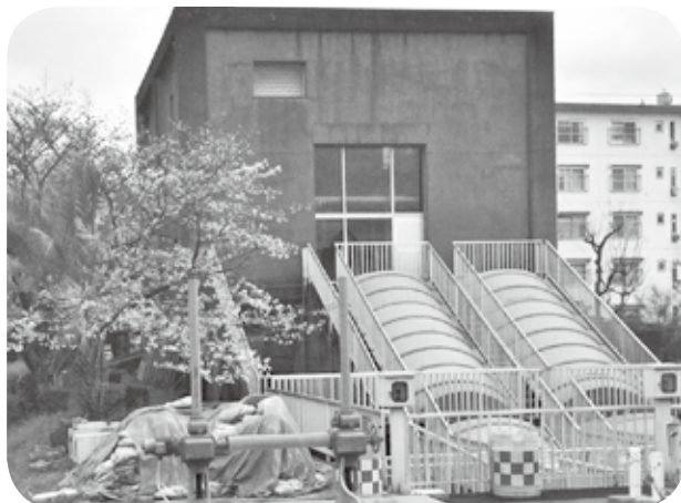
佐山排水機場（更新は令和3年度を予定）
