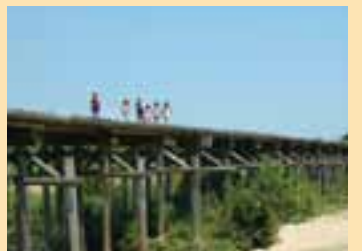
④ 上津屋橋(流れ橋)
