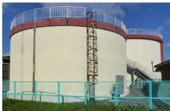
写真 2.8 場外施設配水池
