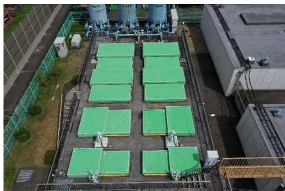
写真 2.5 浄水処理施設全景
