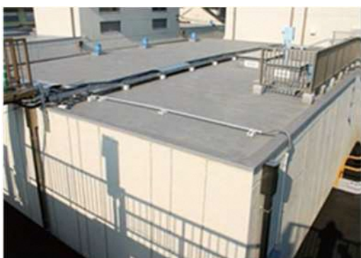
写真 2.7 佐古浄水場配水池
