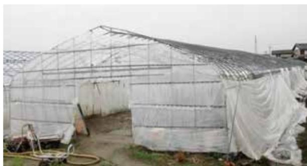
天井ビニールフィルムの早期破損によってアーチパイプ被害を回避できた事例
