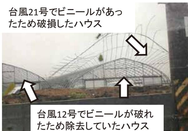
台風12号でビニールが破れたため除去していたハウス
