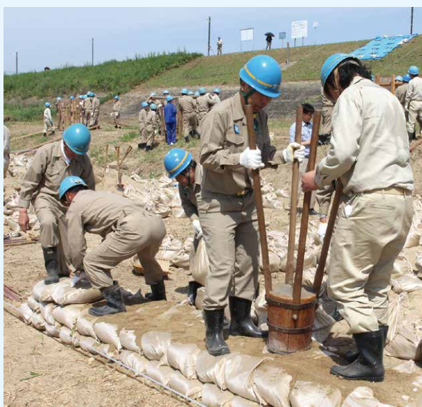
▲積み土のう工の訓練に取り組む水防団員 (5月7日、澁川右岸水防事務組合水防訓練)
