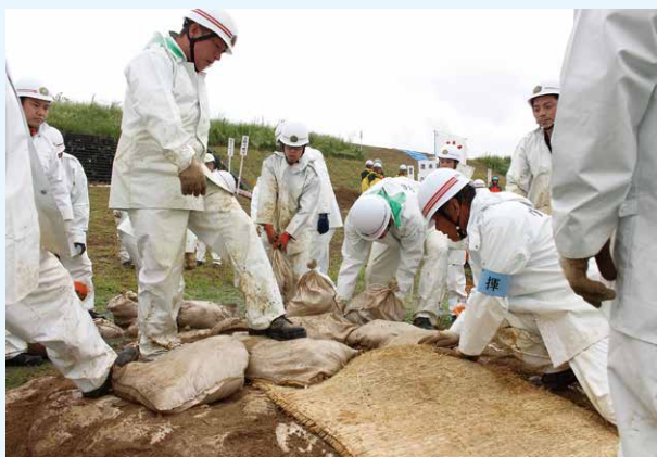
▲釜段工の訓練に取り組む消防団員 (5月13日、淀川・木津川水防事務組合水防訓練)
