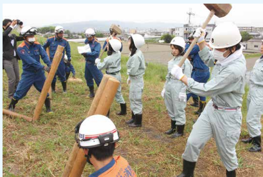
▲杭打ち積み土のう工の訓練に取り組む町職員(5月9日、町水防訓練)
