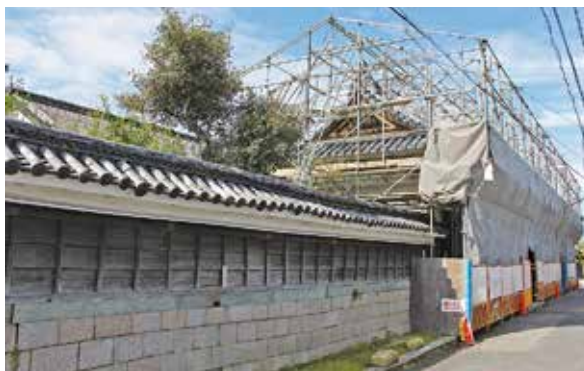
来春の公開再開に向け、改修整備が進む旧山田家住宅
