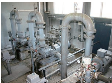
⑩ 配水ポンプ 町内に送水
