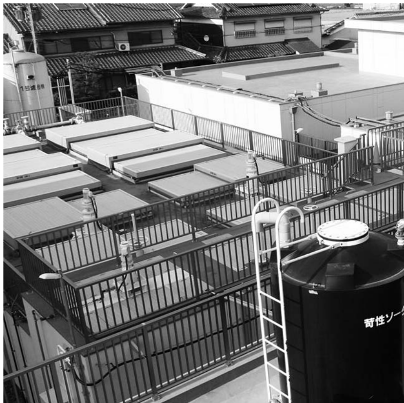
水の工場、佐古浄水場。耐震化工事が終わり、
