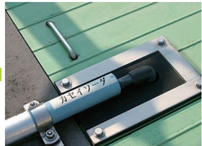
③ 沈砂池 苛性ソーダを注入しPH調整
