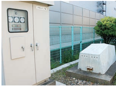
① 取水ポンプ 地下130mの深井戸から汲み上げ
