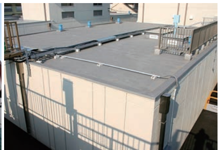
⑧ 配水池 常時3,000tの水を蓄える
