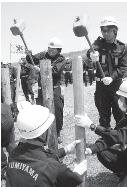
杭打ち積み土のう工に取り組む消防団員
