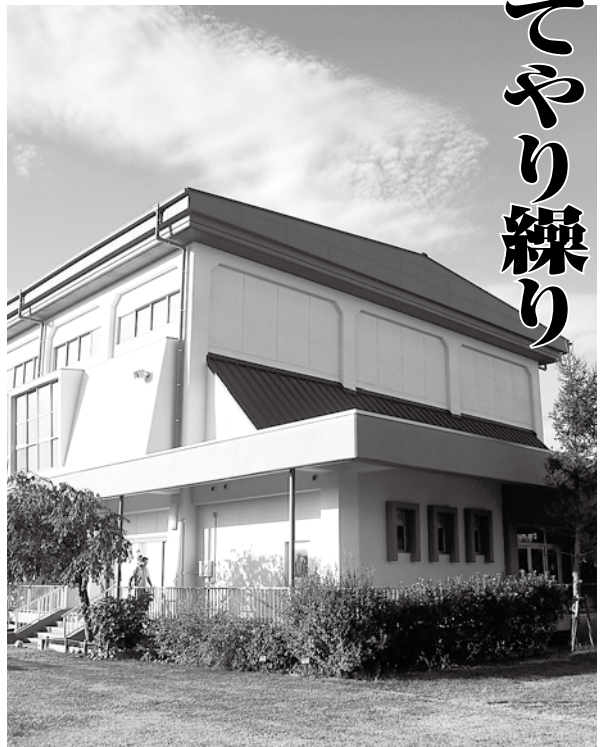
耐震補強された御牧小学校体育館
