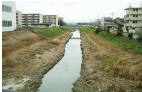
▲古川橋下流付近
