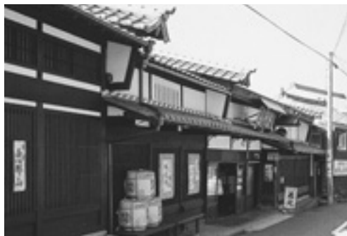
▲屋根に卯建（うだつ）が上がる中津川の町並み
