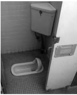
和式トイレを洋式に改修(東角小体育館) *工事完了予定日は 令和5年2月15日
