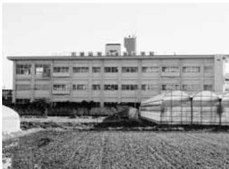
耐震補強と改修の設計が予定されている御牧小学校北校舎
