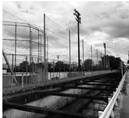
調整池の取水口がつく排水路
