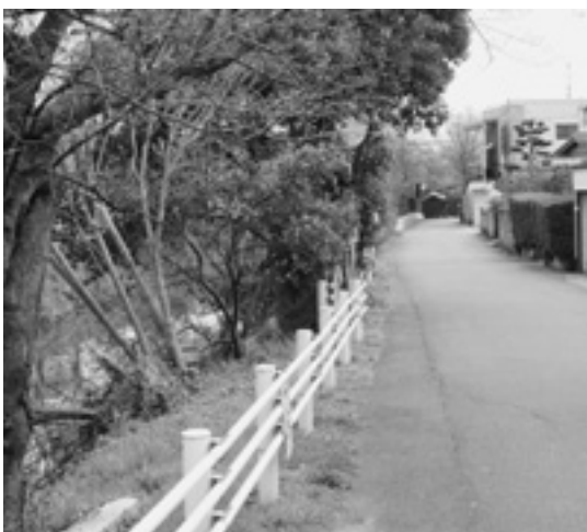
名木川改修にあわせて道路整備が望まれる
