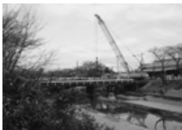
改築される前川橋（東一口）
